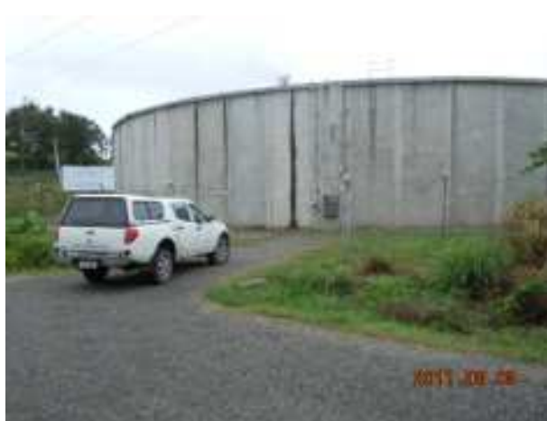
カシミール配水池 (容量 : 20,000m 3 )
