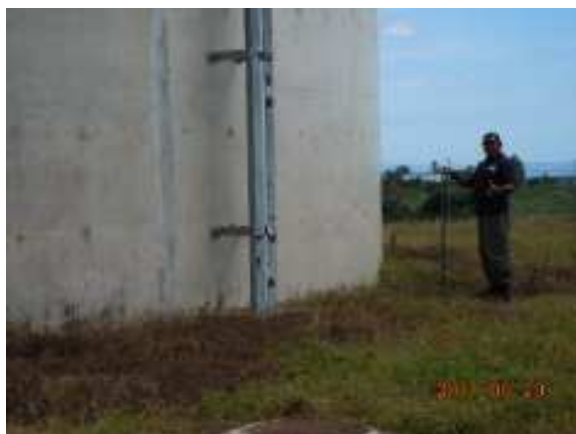
ガリツ配水池の流出弁調整
