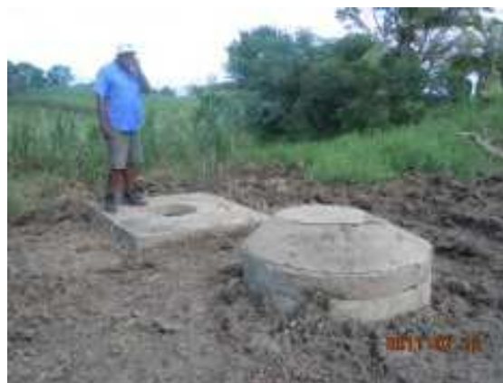
漏水修理の確認（口径 500mm 送水管）
