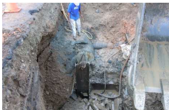
径 800mm と径 600mm の連絡工事
