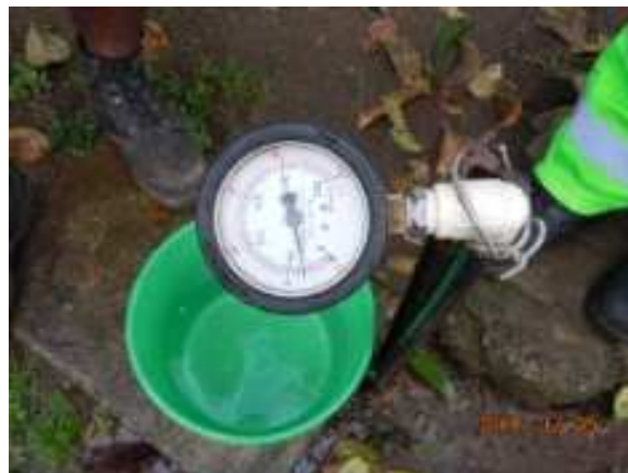
水圧確認（ガリツ配水池の配水区域）
